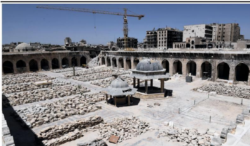
Operazioni di rimozione — nella moschea degli Omayyadi di Aleppo.
